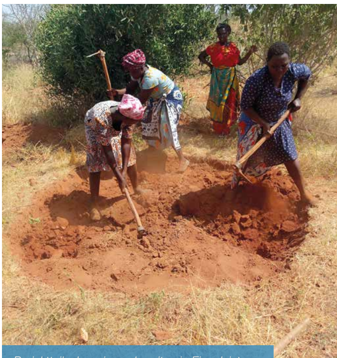
Projektteilnehmerinnen bereiten in Eigenleistung den Bau eines Flachbrunnens vor
