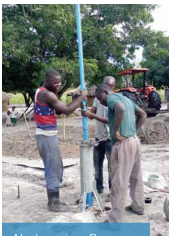
Neubau eines Brunnens
