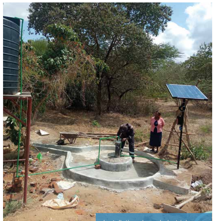
Installation der solarbetriebenen Pumpen für die Brunnen
