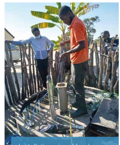
Installation einer Handpumpe
