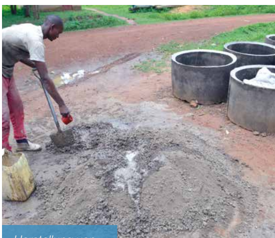
Herstellung von Betonfassungen für Flachbrunnen
