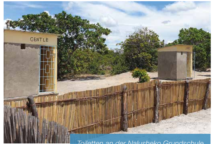
Toiletten an der Nalusheko Grundschule
