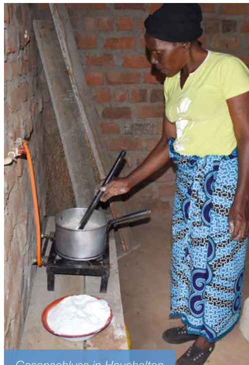
Gasanschluss in Haushalten
