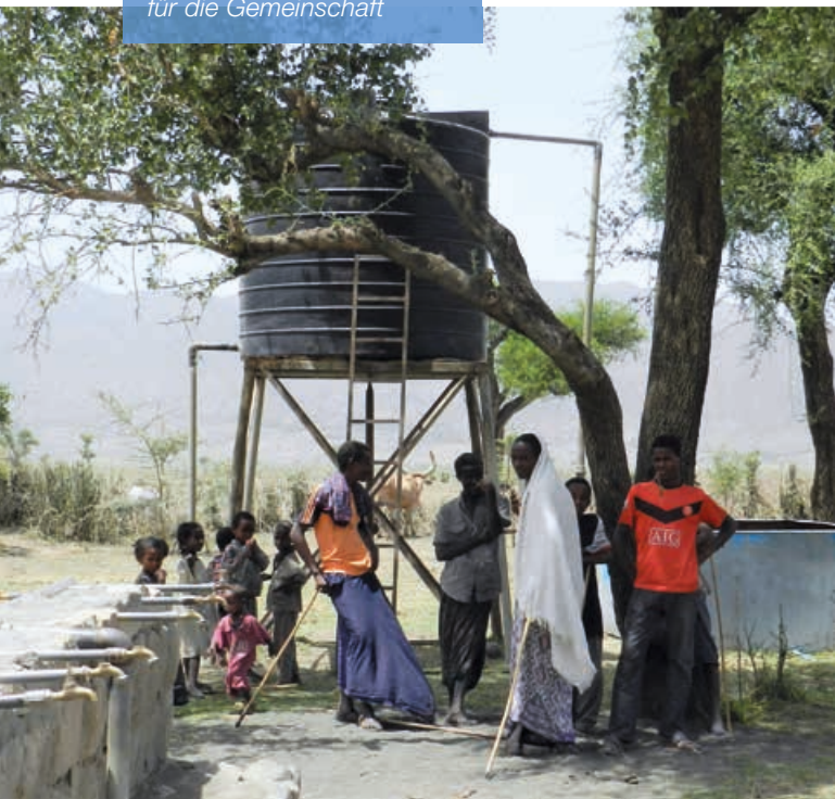
Wasserversorgungsstelle für die Gemeinschaft
