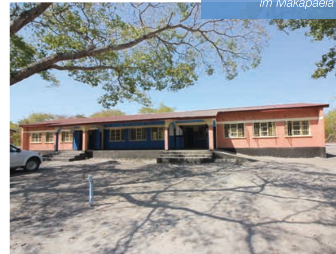
Neues Schulgebäude im Makapaela
