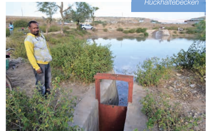
Kanalbau und Rückhaltebecken
