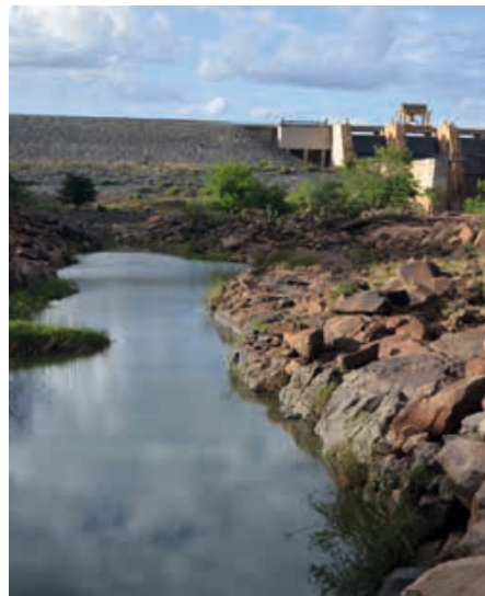
Fluss Tana, von dem aus die Wasserleitung gelegt wird
