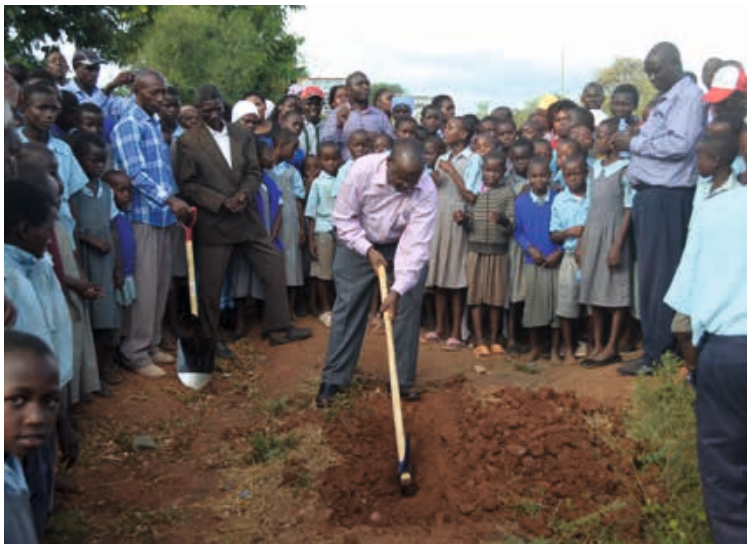
Der Landeskoordinator von Kumea beim Spatenstich für die Wasserleitung
